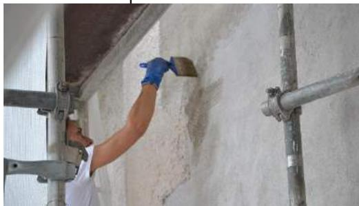
Gli intonaci sono stati consolidati, uniformati nella finitura per le parti incoerenti o degradate, integrati nelle lacune e nelle cadute. Al consolidamento è seguita la velatura dei fondi a correzione dell'eterogeneità dei supporti, con una particolare tecnica a pennello, tampone ed acqua di calce con pigmenti naturali.
